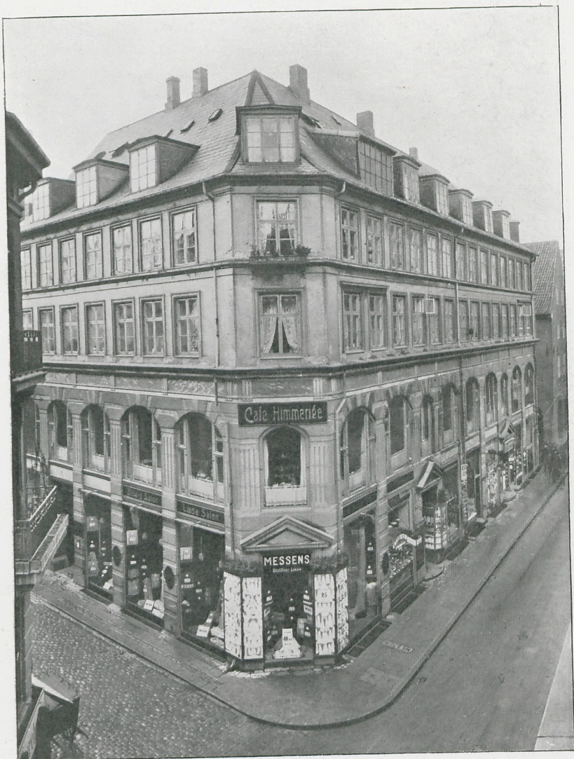
Hjørnet mod Skindergade efter Ombygningen.
